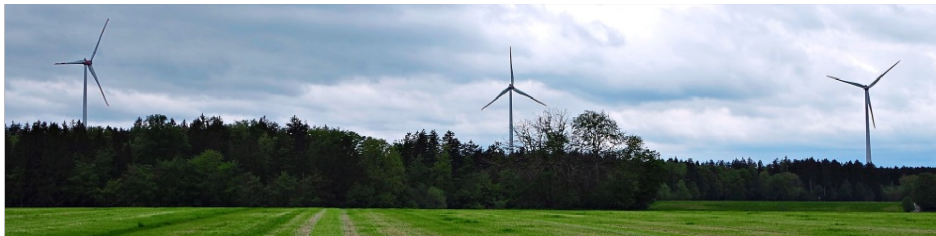
Etwa 1200 Meter Luftlinie von den drei der vier Anlagen des Windparks Wadlhauser Gräben entfernt war der Startpunkt der Exkursion. 2015 wurden sie errichtet. Sie haben eine Nabenhöhe von 149,0 Metern, einen Rotordurchmesser von 115,71 Metern, sind also niedriger als die im hiesigen Staatsforst vorgesehenen.
